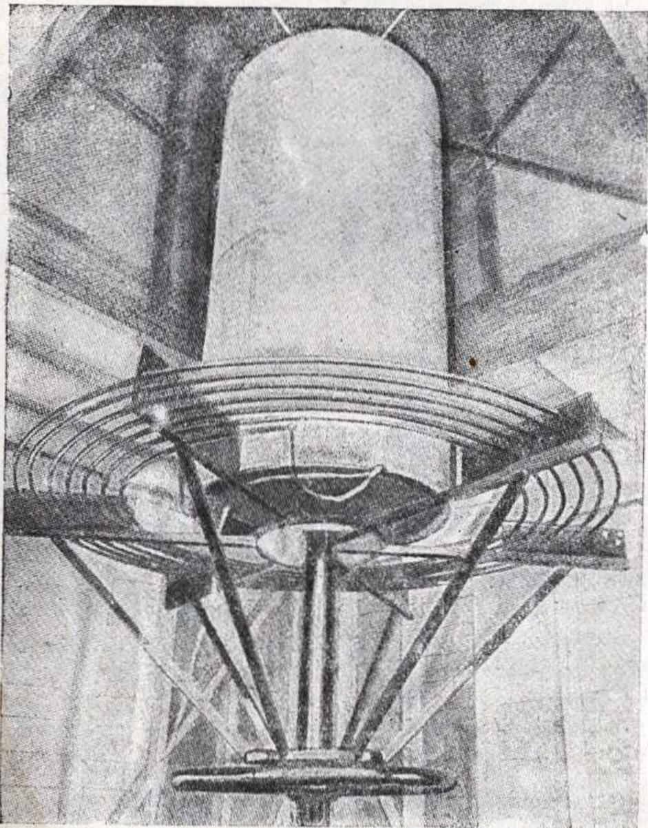
Катушка трансформатора высокого напряжения. Ток от нее проходит к разряднику, установленному над крышей станции
